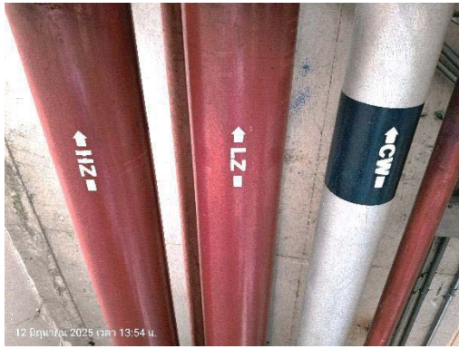
ระบบท่อเย็นสำหรับ Low Zone และ High Zone
