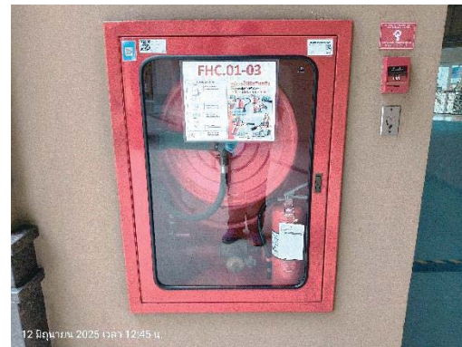
ตู้เก็บสายฉีดน้ำดับเพลิงพร้อมอุปกรณ์ และวิธีใช้
