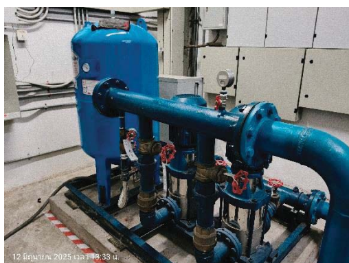
เครื่องสูบน้ำขึ้นอาคาร
